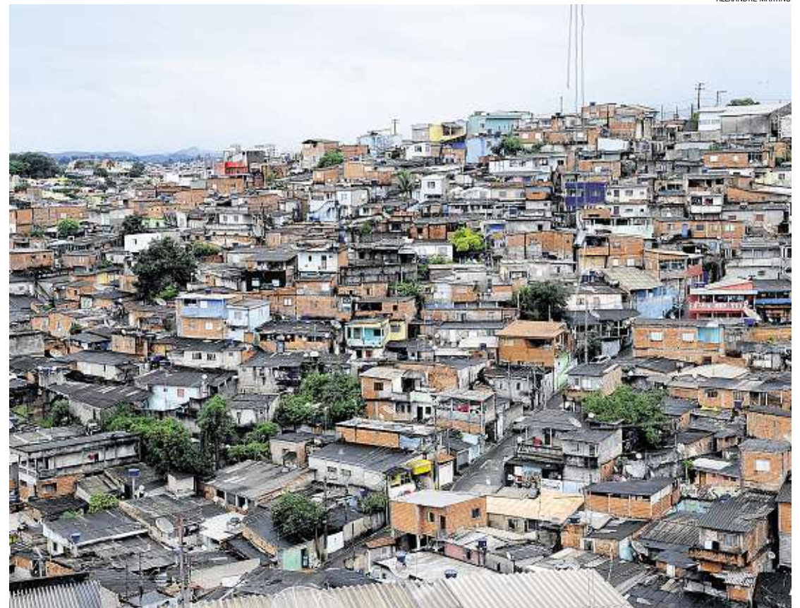
CARA NOVA Novo projeto para a urbanização do São Camilo vai eliminar as construções da encosta e abrir nova via pelo bairro
